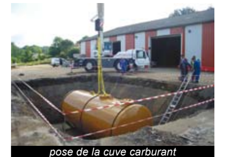
pose de la cuve carburant
